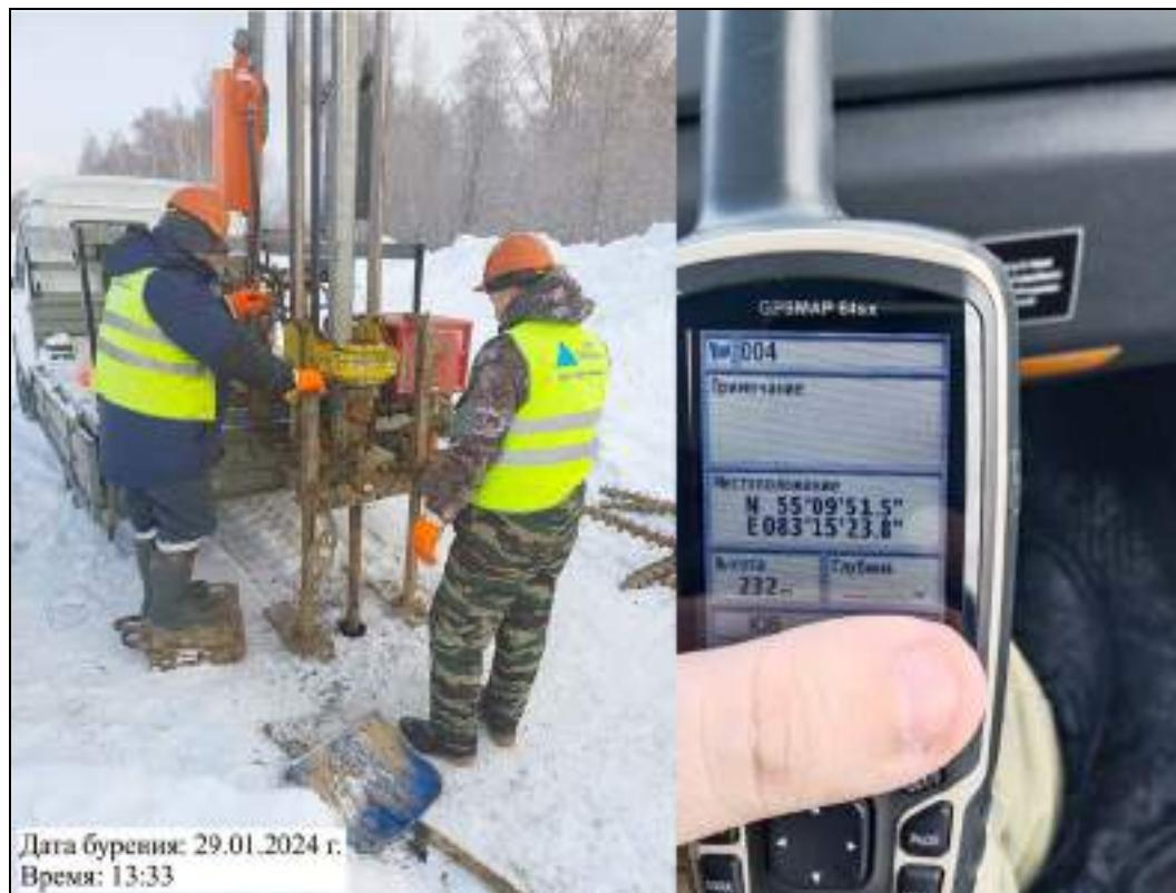
Рисунок У.2 – Фото бурового процесса. Скважина № 4
