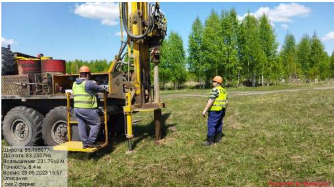
**Рисунок Т.1 - Фрагмент бурения скважины 2**
